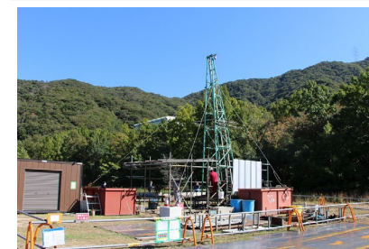
ボーリング調査の様子(2021年10月撮影)
